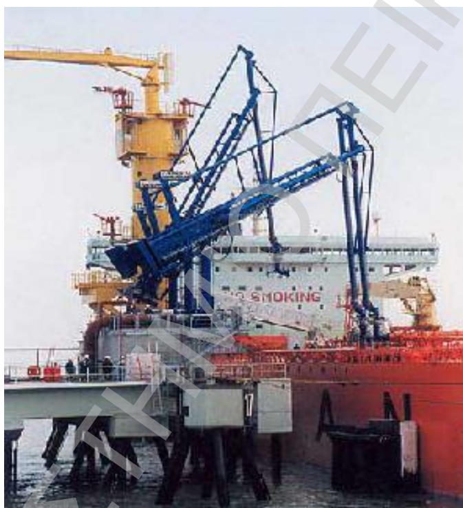
Φωτό: Αρθρωτός βραχίονας φόρτωσης/ εκφόρτωσης υγρού φορτίου
