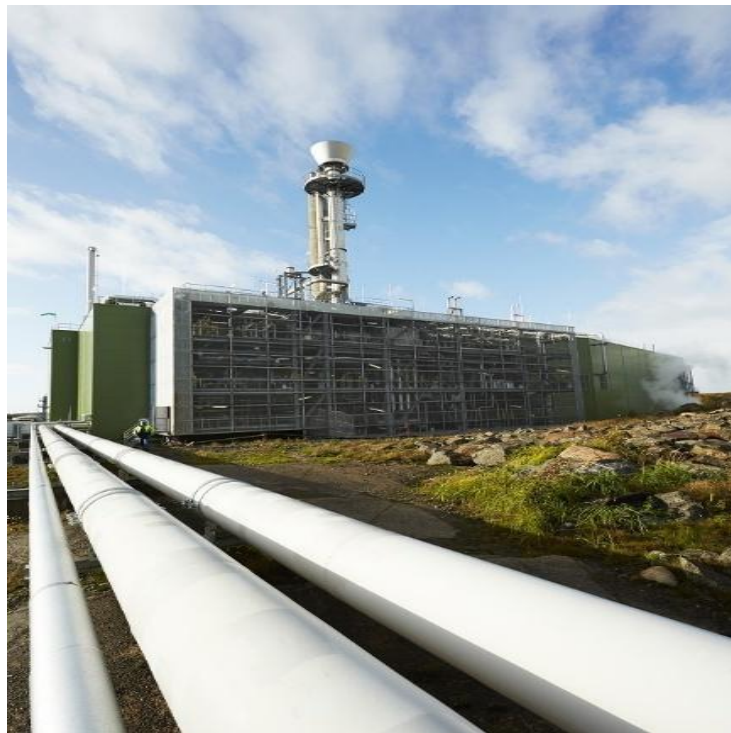
Σχήμα 2. Εγκαταστάσεις Αεριοποίησης, Σουηδία ( http://biomassmagazine.com )
