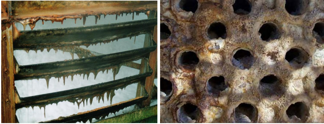
Σχ.16 : ανάπτυξη μικροβιακού φορτίου (οικισμών) σε μέρη του Πύργου Ψύξης
