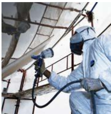
Εικόνα 6 - Εφαρμογή χρωμάτων με σύστημα "airless"
