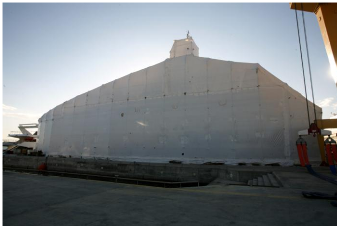
Εικόνα 9 - Δημιουργία κλειστού θαλάμου με σκαλωσιές και ειδικό θερμοσυστελλόμενο νάιλον
