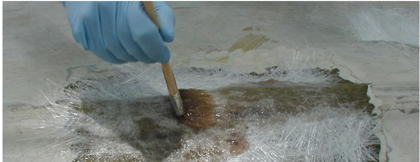
Εικόνα 7 - Πολυεστερική επισκευή
