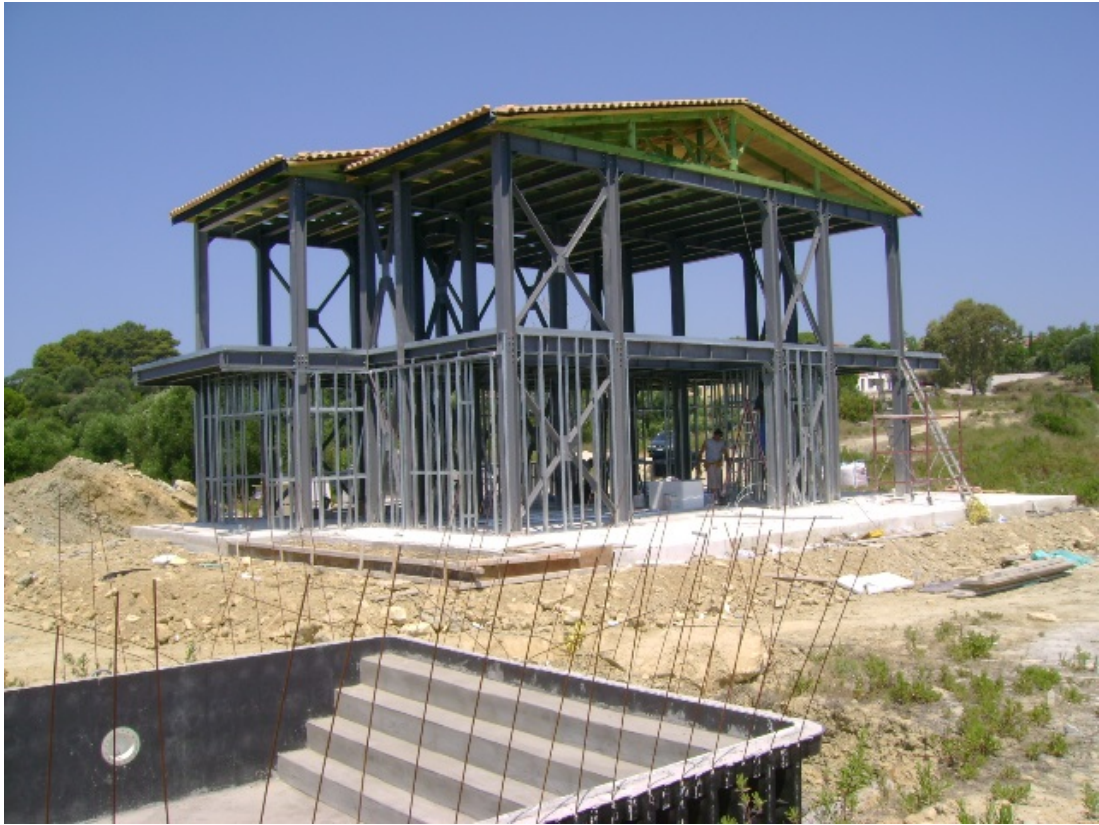
Εικόνα 27. Η κατοικία σε στάδιο κατασκευής του σκελετού της εξωτερικής τοιχοποιίας.
