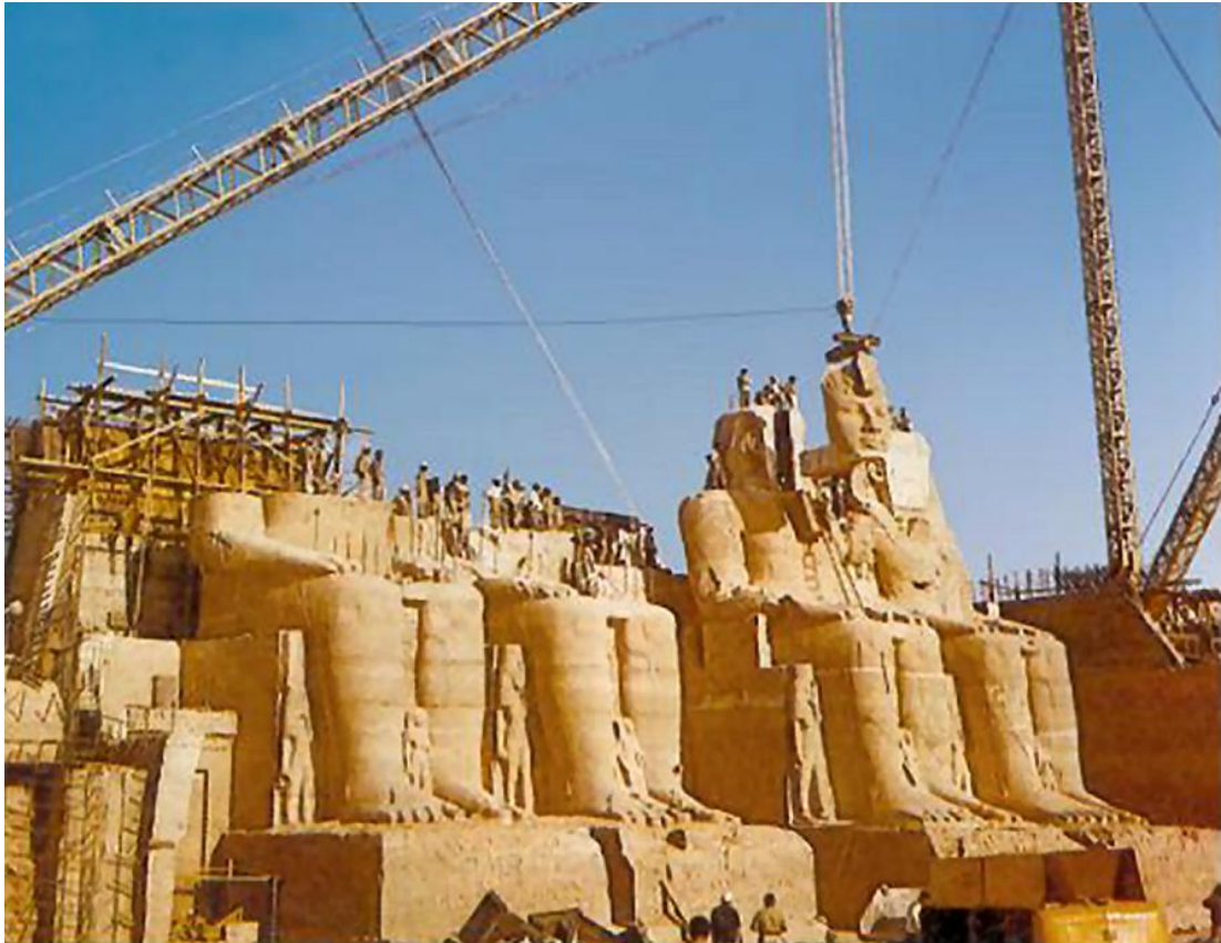
Εικόνα 42. Εργασίες επανακατασκευής της όψης του μεγάλου ναού.
