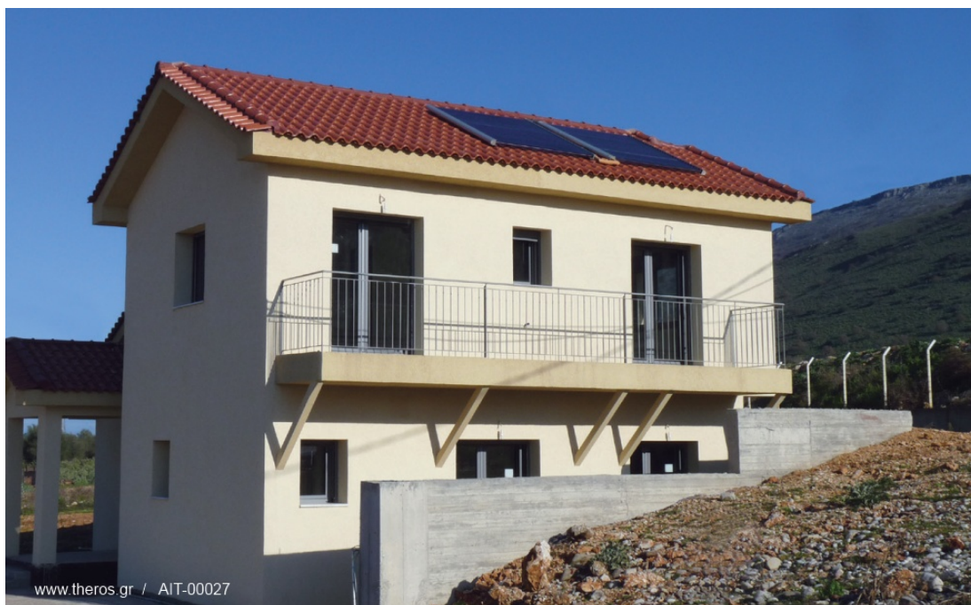
Εικόνα 21. Το πλήρες κτήριο στην Αμφιλοχία στα πλαίσια της έρευνας I.S.S.B ολοκληρωμένο.
