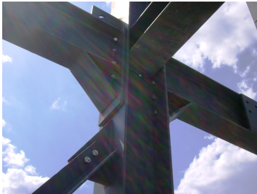
Εικόνα 23. Λεπτομέρεια κόμβου του μεταλλικού στατικού φορέα.
