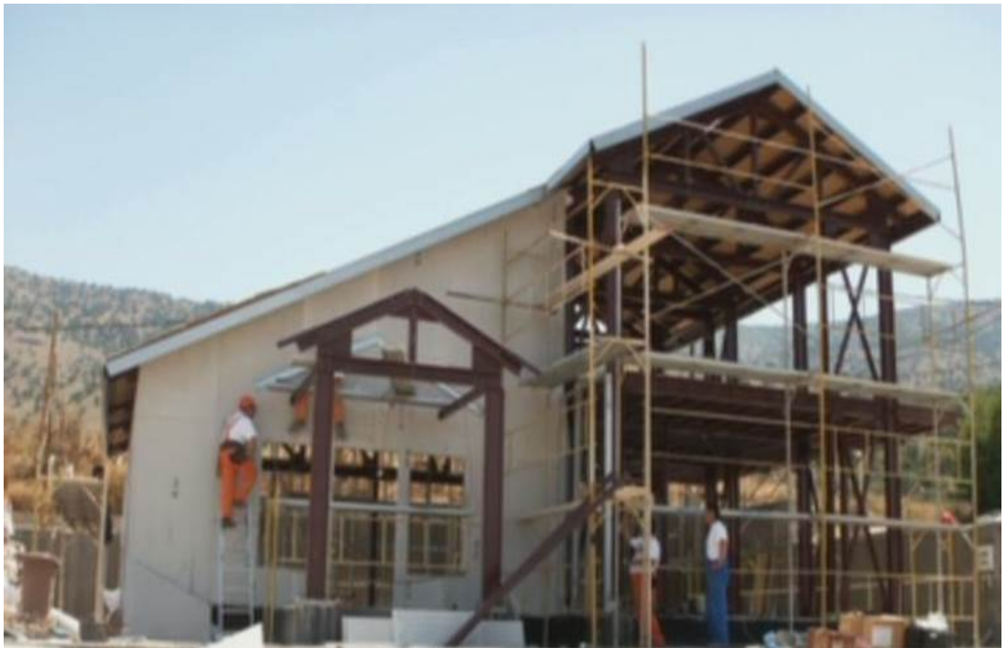
Εικόνα20. Το πλήρες κτήριο στην Αμφιλοχία στα πλαίσια της έρευνας I.S.S.B. σε φάση κατασκευής.
