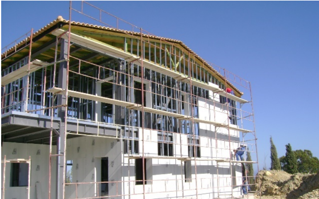
Εικόνα 25. Η κατοικία σε στάδιο κατασκευής της εξωτερικής τοιχοποιίας με τον σκελετό χαύβδοελάσματος καθώς τοποθετούνται οι τσιμεντοσανίδες πάνω σε αυτόν.(Εξωτερική άποψη)
