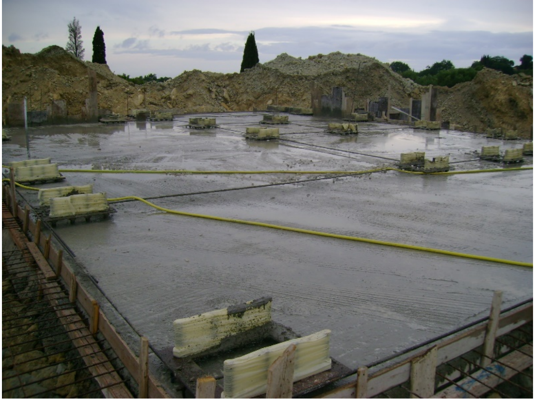
Εικόνα 32. Η θεμελίωση του κτηρίου.
