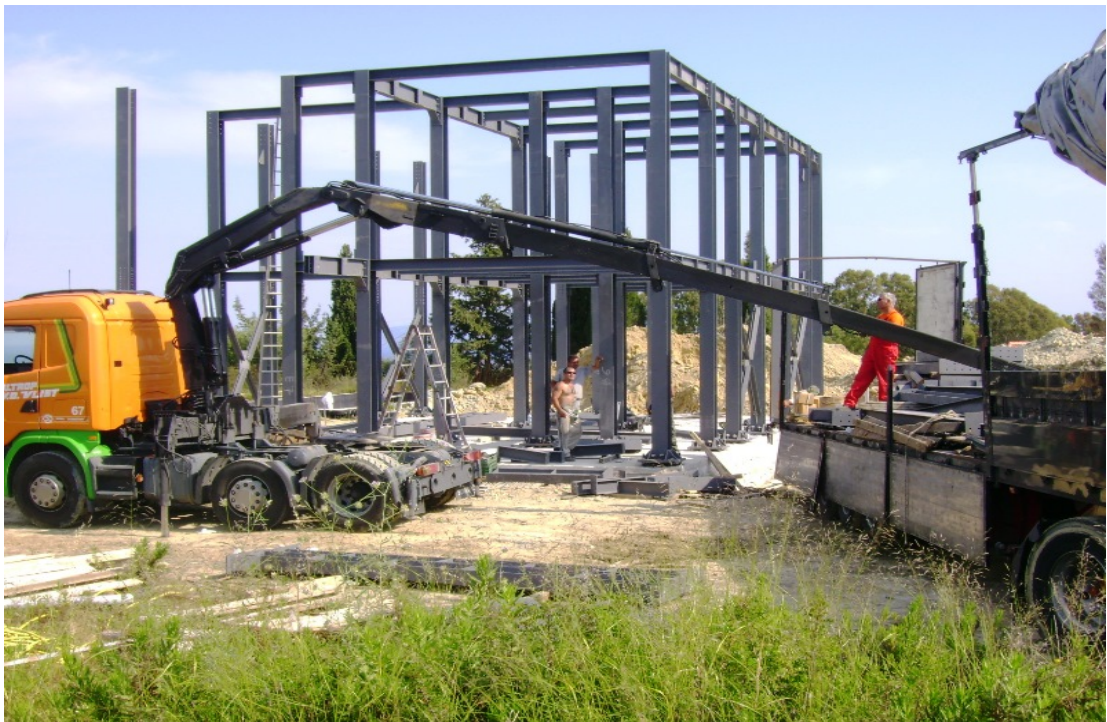
Εικόνα 31α,31β. Ο μεταλλικός στατικός φορέας σε φάση συναρμολόγησης.
