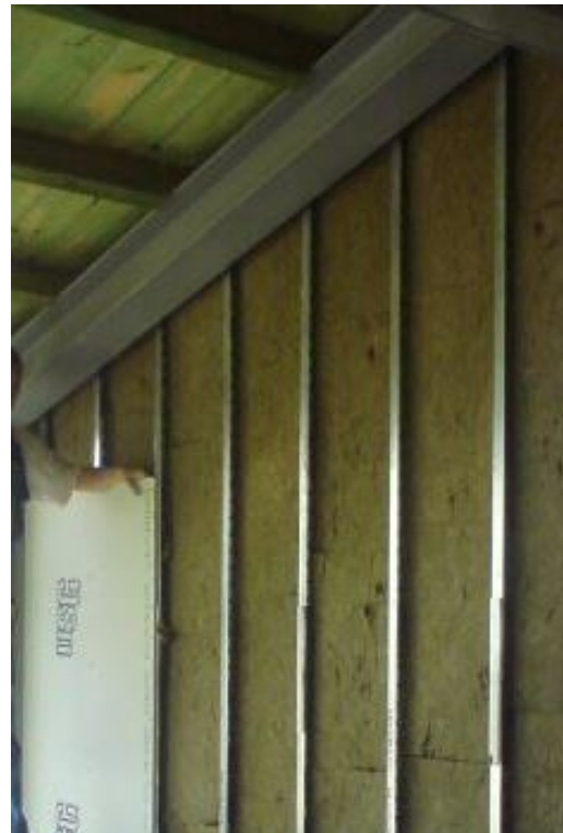
Εικόνες 26α,26β. Η κατοικία σε στάδιο κατασκευής της εξωτερικής τοιχοποιίας με τον σκελετό χαύβδοελάσματος καθώς τοποθετούνται οι τσιμεντοσανίδες πάνω σε αυτόν.(Εσωτερική άποψη
