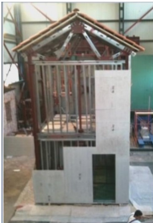
Εικόνα 18. Φάση κατασκευής τοιχοποιίας του πειραματικού κτιρίου στην σεισμική τάπεζα του Ε.Μ.Π. στα πλαίσια της έρευνας I.S.S.B.
