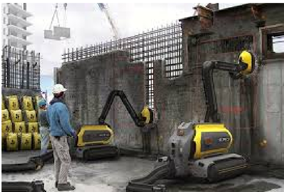
Εικόνα 17. Διαχωρισμός αδρανών από το χάλυβα με υδροβολή σε σπλισμένο σκυρόδεμα.
