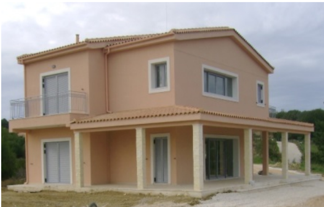
Εικόνα 22. Κατοικία με μεταλλικό στατικό φορέα και τοιχοποιία στην Κεφαλλονιά
