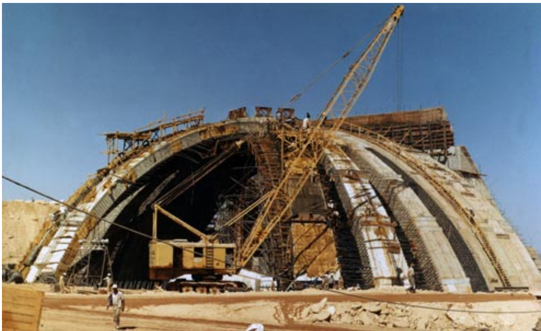
Εικόνα 43. Εργασίες κατασκευής του θόλου του μεγάλου ναού.
