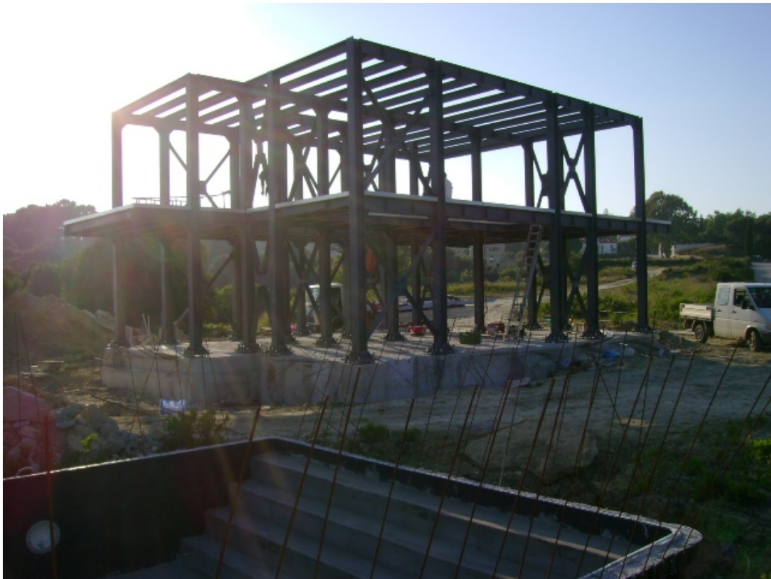
Εικόνα 29. Ο μεταλλικός στατικός φορέας ολοκληρωμένος.
