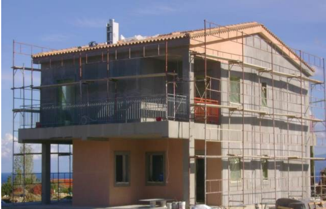
Εικόνα 24. Η κατοικία σε στάδιο χρωματισμών χωρίς τα εξωτερικά κουφώματα.
