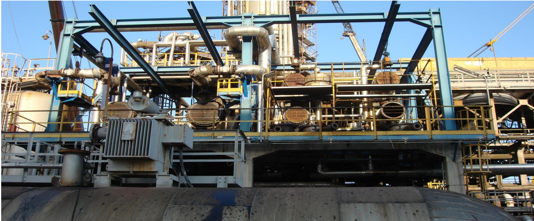
Εικόνα 8 - Σύστημα Εναλλακτών Θερμότητας
