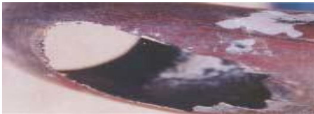
Εικόνα 2 - Μεταλλική Διάβρωση σε U – καμπή
