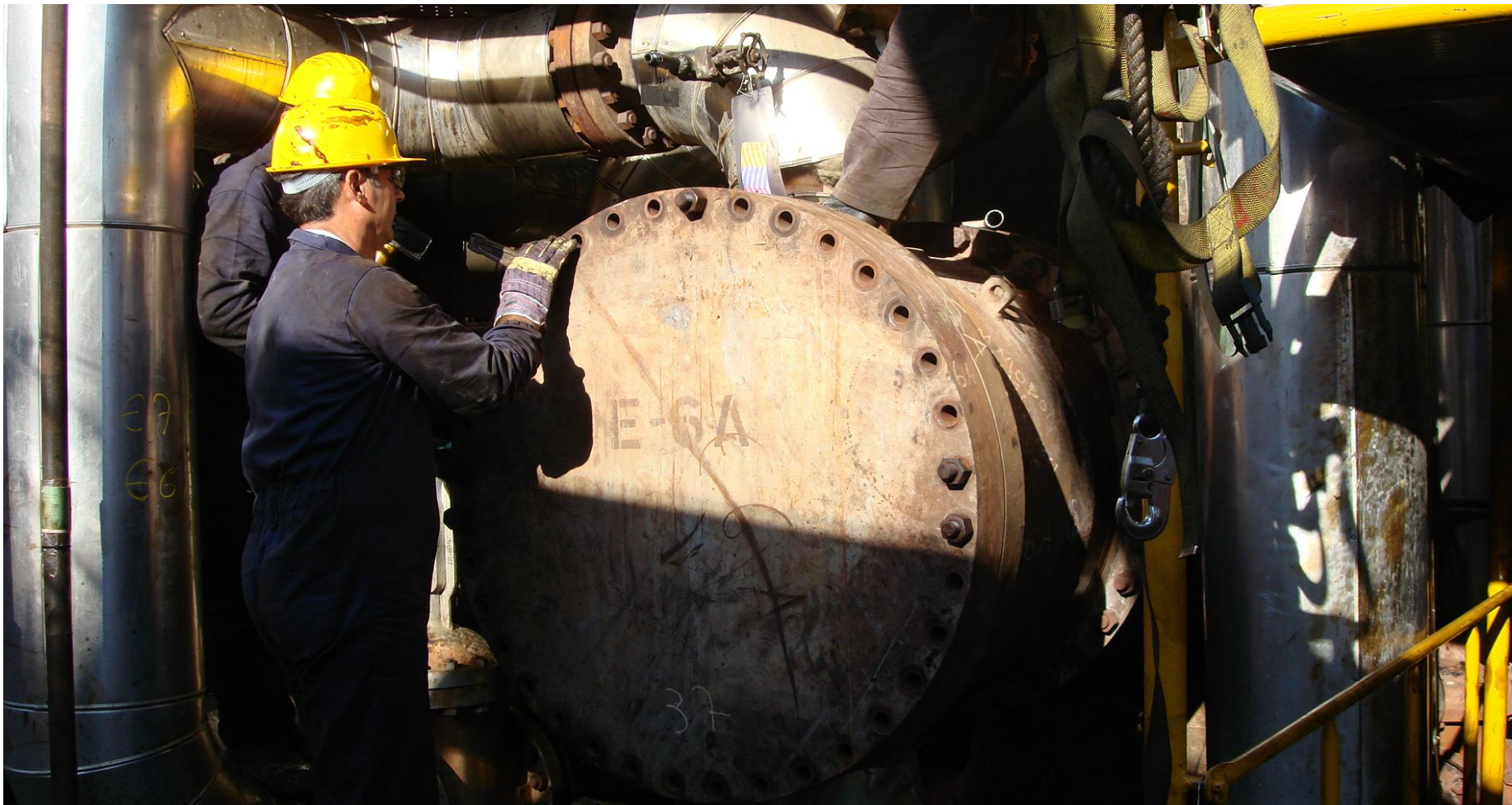
Εικόνα 12 - Αφαίρεση Φλάντζας Εναλλάκτη
