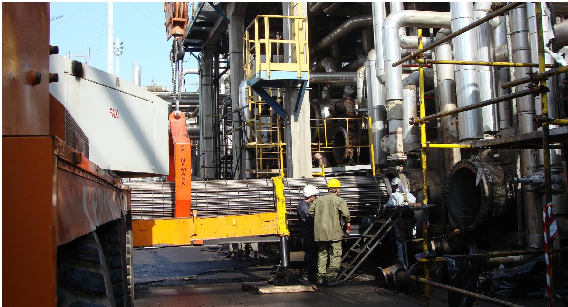
Εικόνα 15 – Σύστημα Εξάρμωσης Τουμποστοιχείων Εναλλακτών
