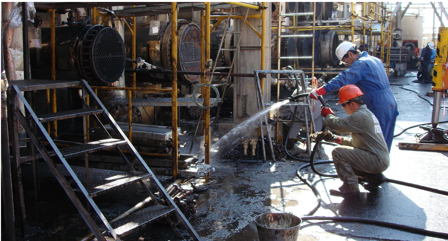
Εικόνα 14 – Καθαρισμός Χώρου Εναλλακτών Θερμότητας
