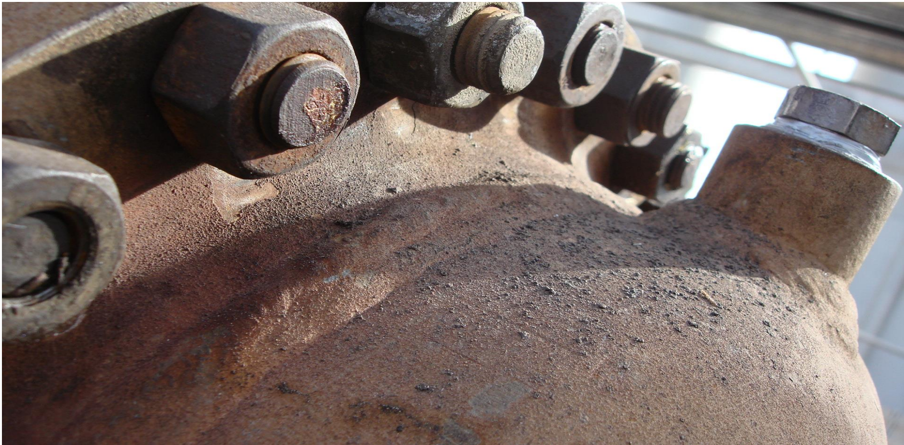
Εικόνα 11 - Σύσφιξη Καμπάνας Εναλλάκτη
