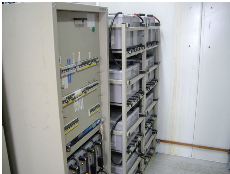
Σχήμα 10: Ανορθωτικό και συστοιχία μπαταριών
