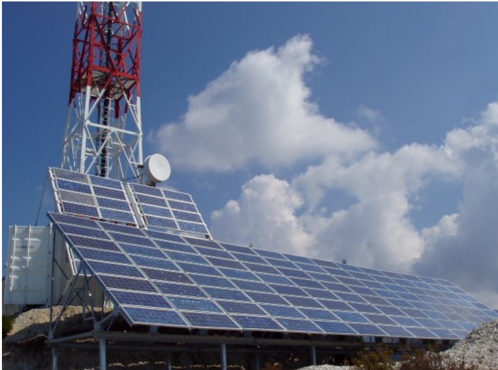
Σχήμα 15: Φωτοβολταϊκοί υβριδικοί σταθμοί
