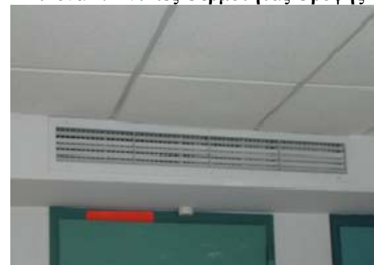
Εικόνα 9: Τερματική μονάδα οροφής
