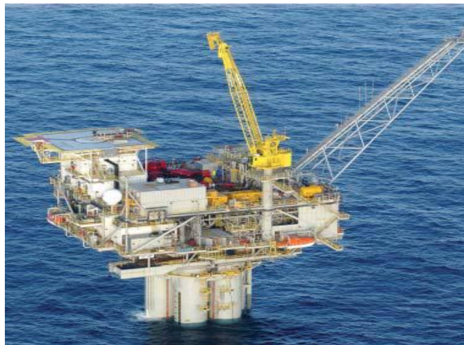
Εικόνα 5.17: Red Hawk, τεχνολογίας spar cell
