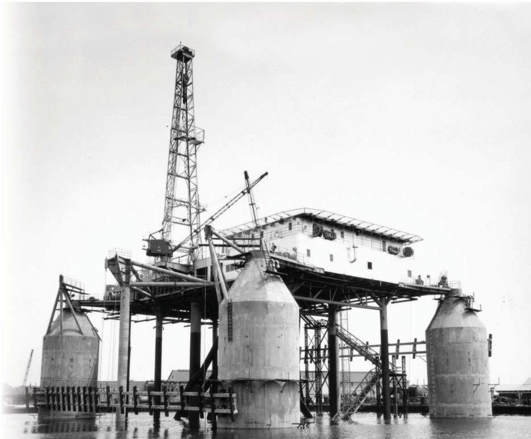
Εικόνα 5.9: Delta Offshore No. 46, η πρώτη σταθερή υποβρύχια στήλη.
