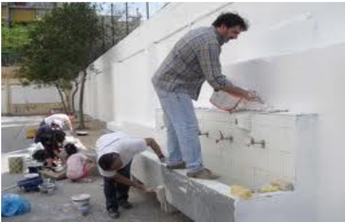
Εικόνα.18.Κατασκευή σχολείου στην Ελλάδα.
