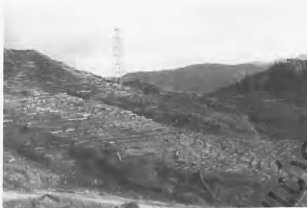
Εικόνα 7.1 Κατασκευή κορμοδεμάτων στην Αρχαία Ολυμπία.
