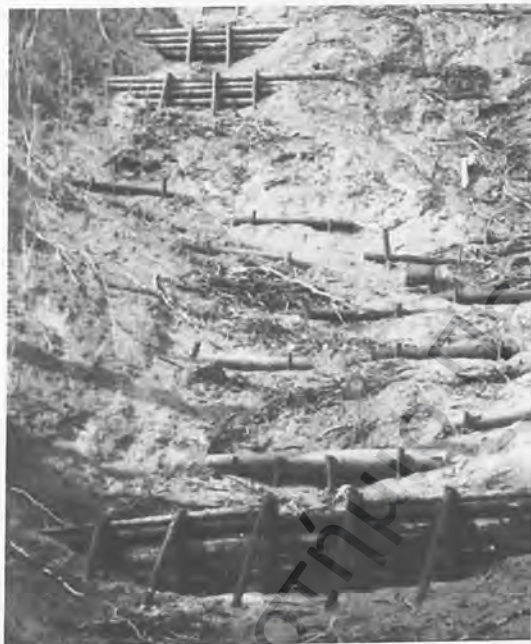
Εικόνα 7.2 Κατασκευή κορμοφραγμάτων στην περιοχή της Αρχαίας Ολυμπίας.
