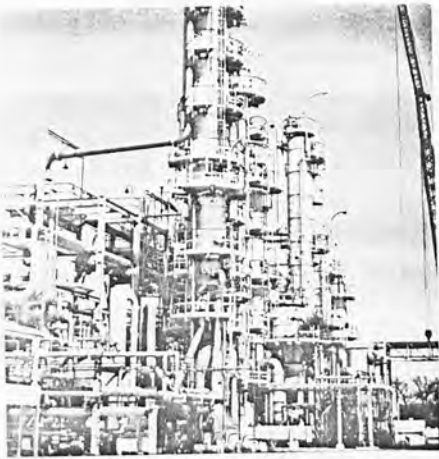
ΕΙΚΩΝ I-4. Ήθργοι καθαρισμού είς τό τμήμα μονομερούς χλωροπρενίου.
