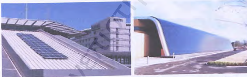
Εικ. 3.1 Ενσωμάτωση φωτοβολταϊκών στο σταθμό του μετρό στο αεροδρόμιο Ελευθέριος Βενιζέλος (α) και σε δημόσιο κτίριο (β) (ΣΕΦ)
