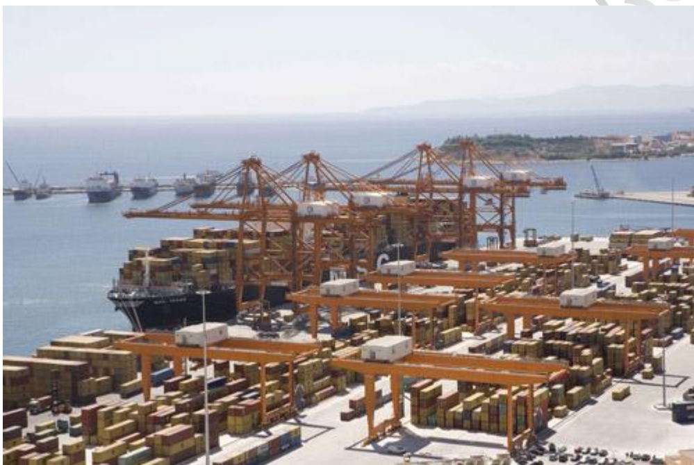
Εικόνα 10: Σταθμός Εμπορευματοκιβωτίων Λιμένα Πειραιά
