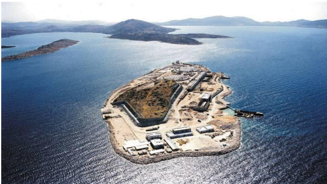
Εικόνα 12: Τερματικός Σταθμός Υγροποιημένου Φυσικού Αερίου Ρεβυθούσας
