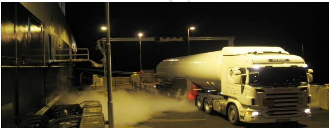
Εικόνα 2: Ανεφοδιασμός LNG από βυτιοφόρο όχημα
