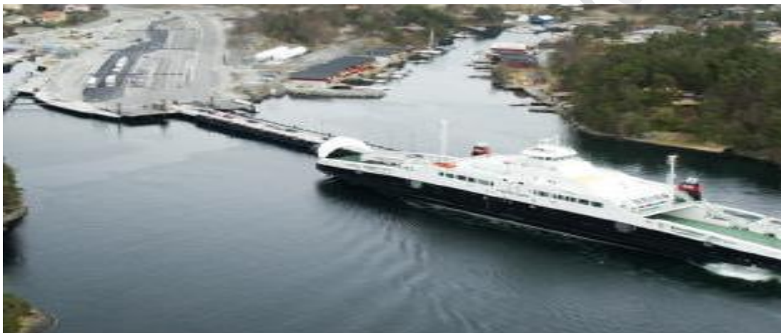
Εικόνα 4 : Ανεφοδιασμός LNG από Εγκαταστάσεις Ξηράς μέσω σταθερών εφοδιαστικών γραμμών
