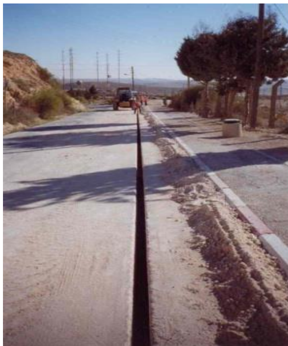
Εικόνα 12 : Η μικροτάφρος (mini-trench) αναφέρεται σε κατασκευή μικρών τάφρων για εγκατάσταση υπόγειων καλωδίων οπτικών ινών και χάλκινων καλωδίων [πηγή: ΟΤΕ Α.Ε.]
