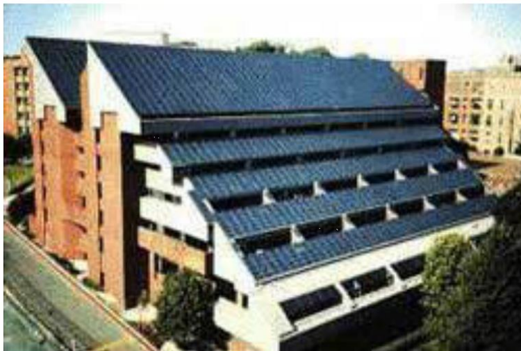
Φωτογραφία 3.2: Ενσωματωμένα φωτοβολταϊκά στοιχεία στο κτηριακό κέλυφος
