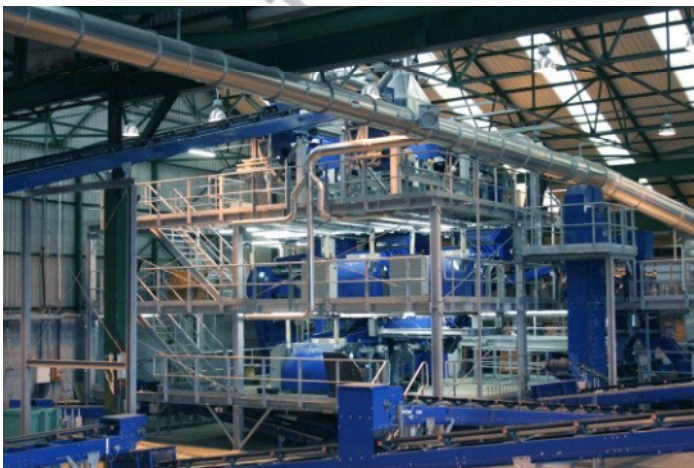
Εικόνα 38 Εργοστάσιο ανακύκλωσης γυαλιού που παρέχεται από την Mogensen, Γερμανία. Πηγή: RLG-presentation, 2012
