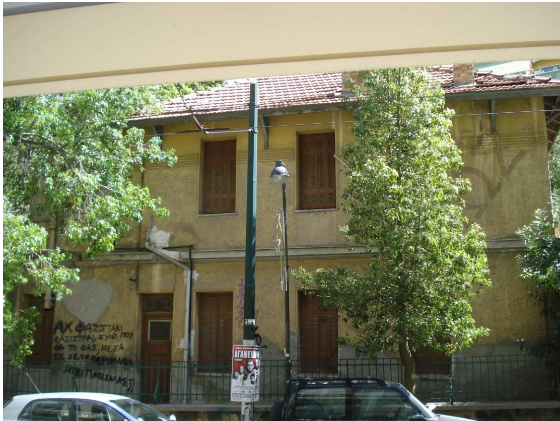
Εικόνα 2.3 Ανατολική Όψη του κτιρίου
