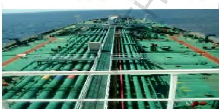
Εικόνα 7.2 Σωλήνες φόρτωσης, κύριο κατάστρωμα
