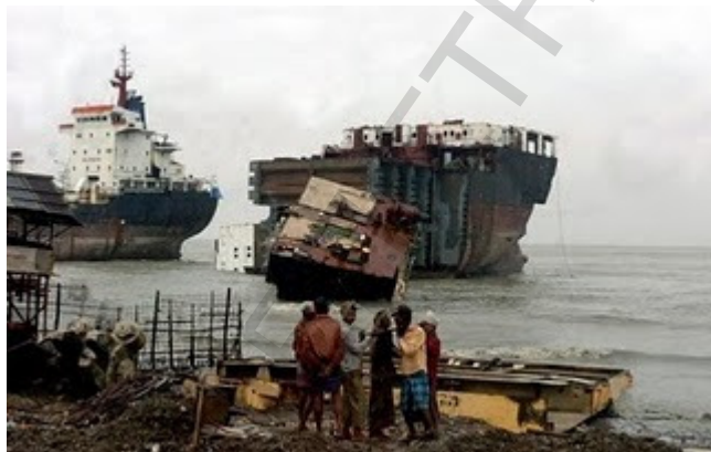
Εικόνα 3: στιγμιότυπο από τη διάλυση πλοίων σε ακτή της νοτιοανατολικής Ασίας
