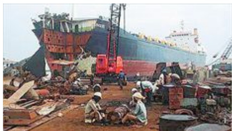
Εικόνα 4: στιγμιότυπο από τη διάλυση δεξαμενόπλοιου σε ακτή της νοτιοανατολικής Ασίας.
