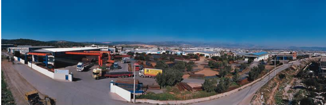
Εικ 5.3.6 Οι εγκαταστάσεις της Εταιρείας
