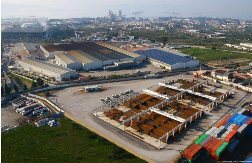
Εικ. 5.3.4 Εγκαταστάσεις του Ομίλου στον ΑΣΠΡΟΠΥΡΓΟ
