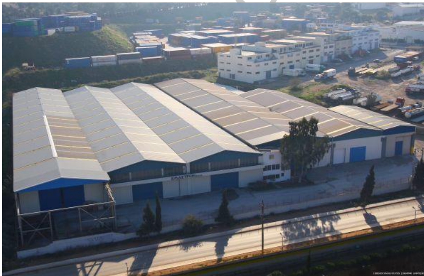
Εικ. 5.3.5 Εγκαταστάσεις του Ομίλου στον ΣΚΑΡΑΜΑΓΚΑ
