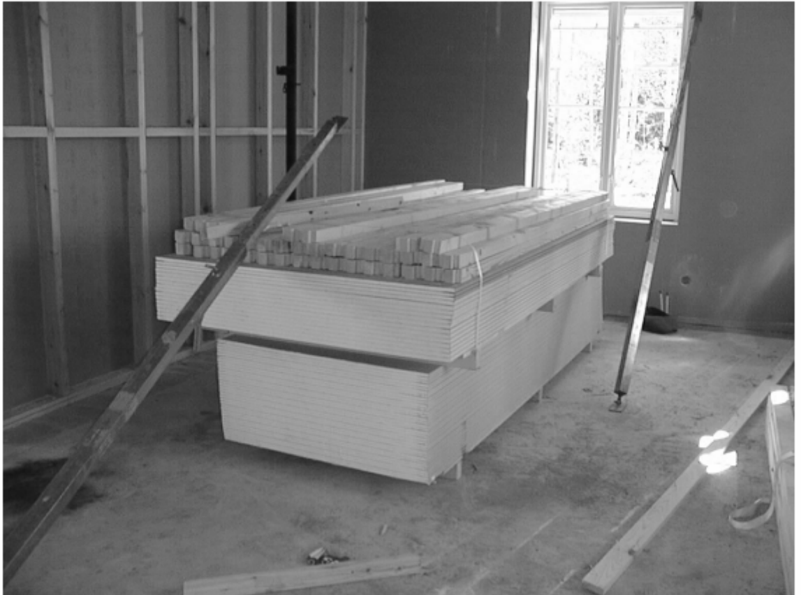
Σχήμα 36: Κατασκευαστικά υλικά τοποθετημένα στο χώρο συναρμολόγησης
