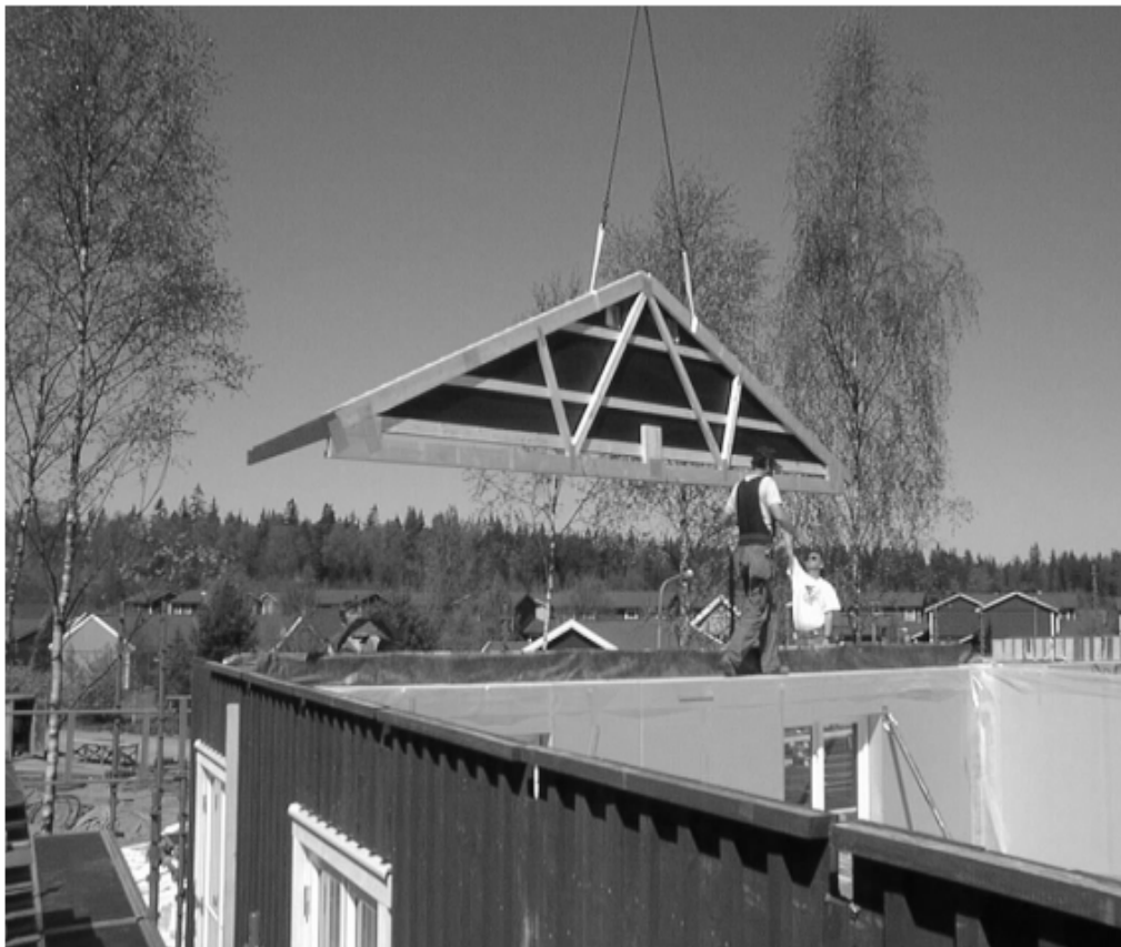
Σχήμα 35: Κατασκευαστικό μέρος ειδικό να διευκολύνει το ξεφόρτωμα
