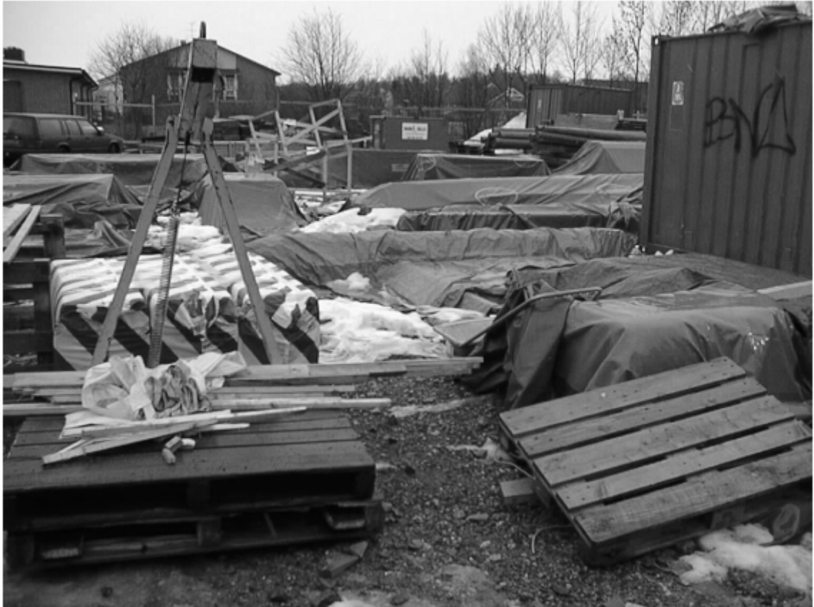
Σχήμα 15: Τα υλικά σε ένα εργοτάξιο
