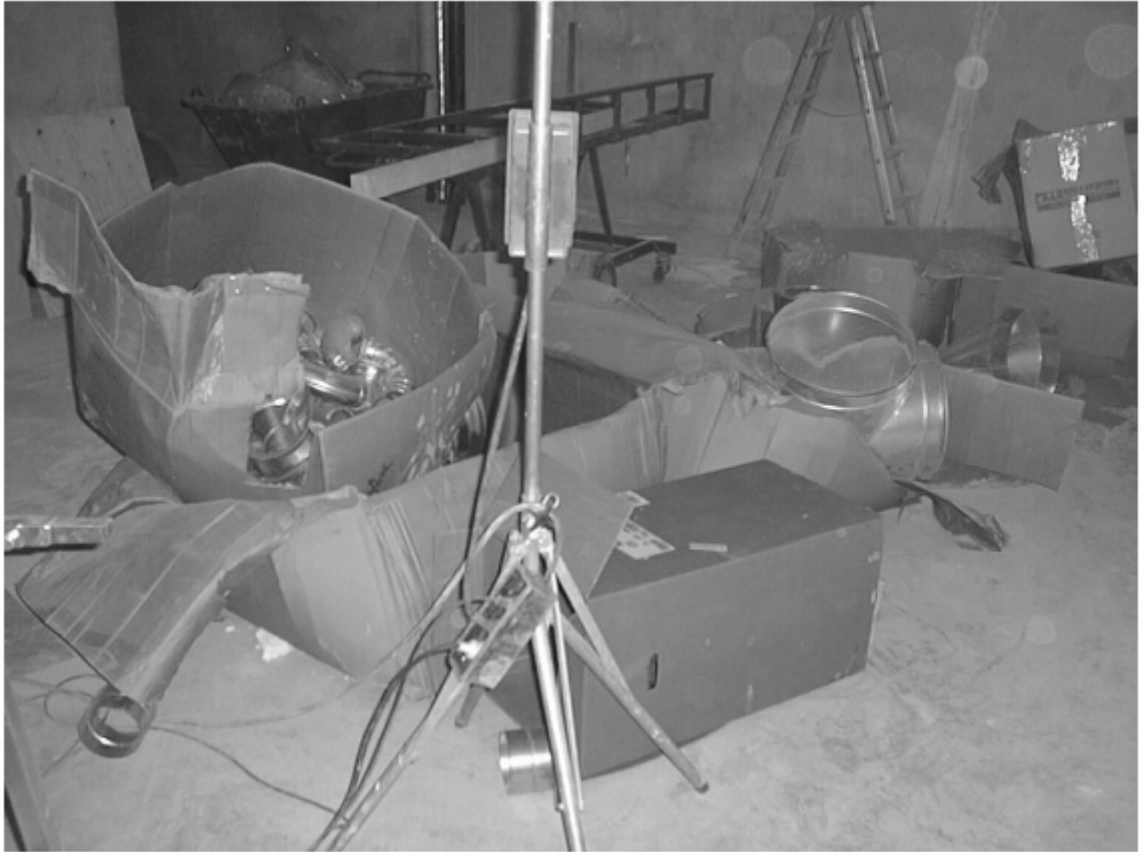
Σχήμα 21: Υλικά εγκατάστασης στο εργοτάξιο
