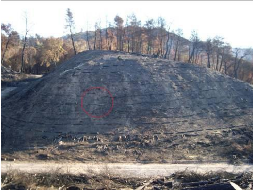
Φωτογραφία 8. Διάταξη κορμοδεμάτων τύπου μωσαϊκού στο λόφο Καλόσακα (Πηγή: ΕΘΙΑΓΕ).
