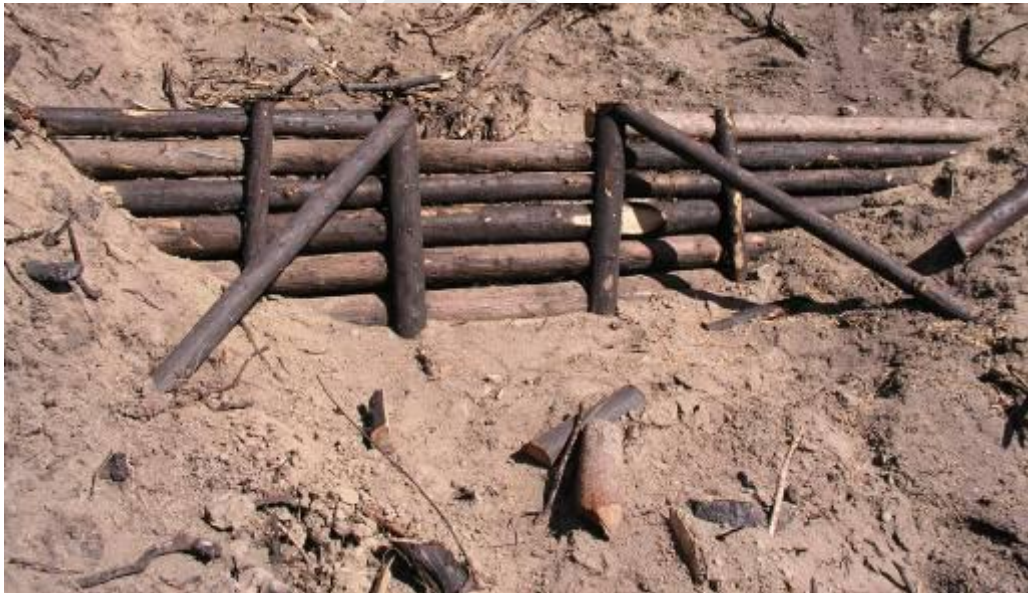
Φωτογραφία 9. Κατασκευή κορμοφραγμάτων στο λόφο Καλόσακα (Πηγή: ΕΘΙΑΓΕ)
