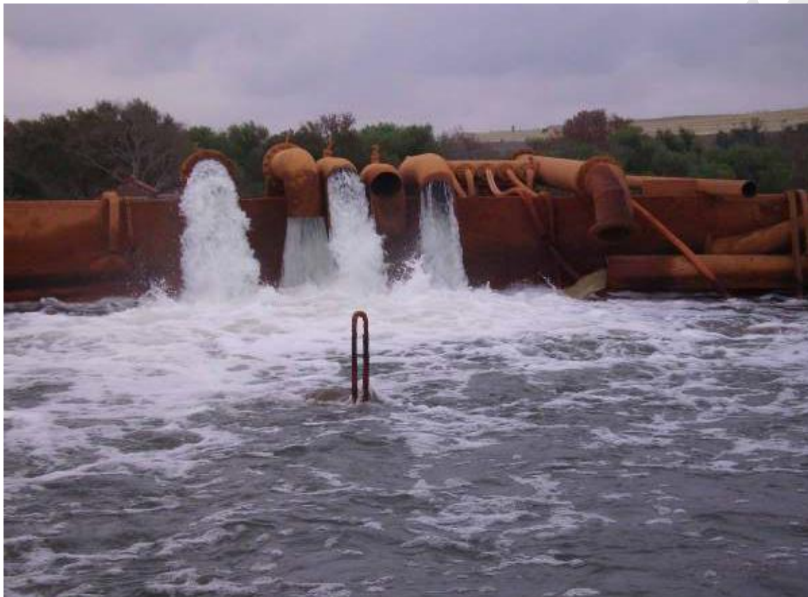
Εικόνα 5: Μεταφορά ΟΑΜ διαμέσου αντλιών από την κοίτη ενός ποταμού στο εργοστάσιο που έχει εγκατασταθεί για την επεξεργασία της.
