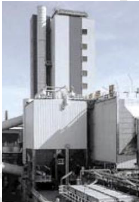
Εικόνα 4.11. Ο κλιβανός IsaSmelt της Umicore (Πηγή: Hagelüken, 2006).
