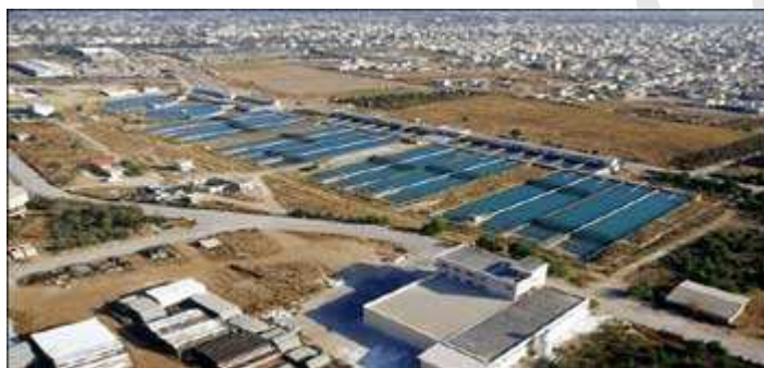
MEN (Μονάδα Επεξεργασίας Νερού) Αχαρνών
