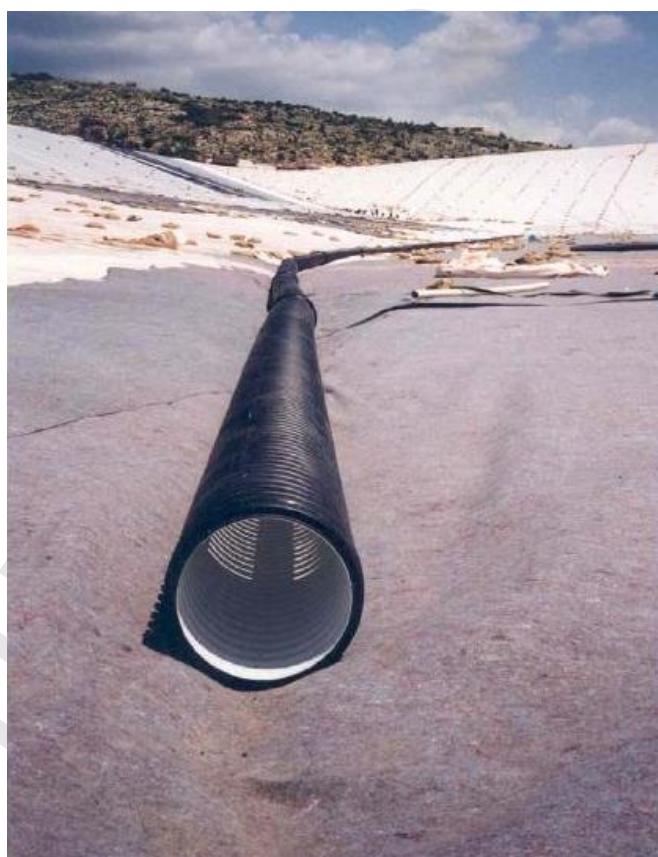
Εικόνα 10: Τοποθέτηση γεωφασμάτων και αγωγών στον ΧΥΤΑ
