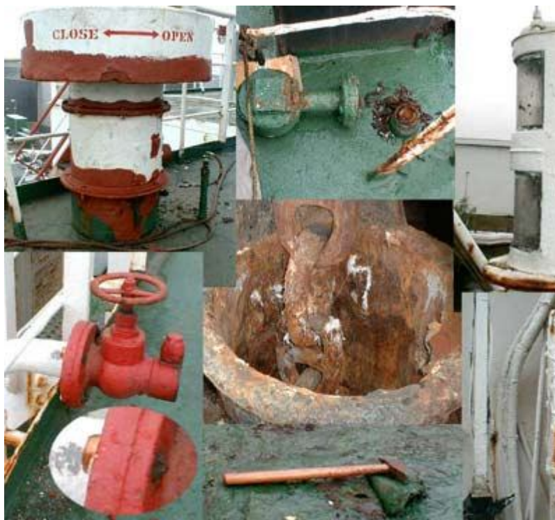
Σχήμα 04, Εικόνες διάβρωσης σε διάφορα σημεία του σκάφους, http://maritimesafety.pmo.ir/flagandportstatecontrol-highlightofpscactivities-en.html
