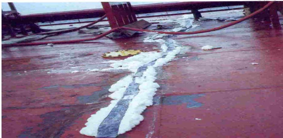
Εικόνα 2-4: Η ρωγμή στο κατάστρωμα του “Castor” 10 .
