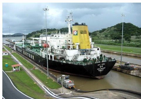
Εικόνα 10-Τεχνητές δεξαμενές στη διώρυγα του Παναμά
