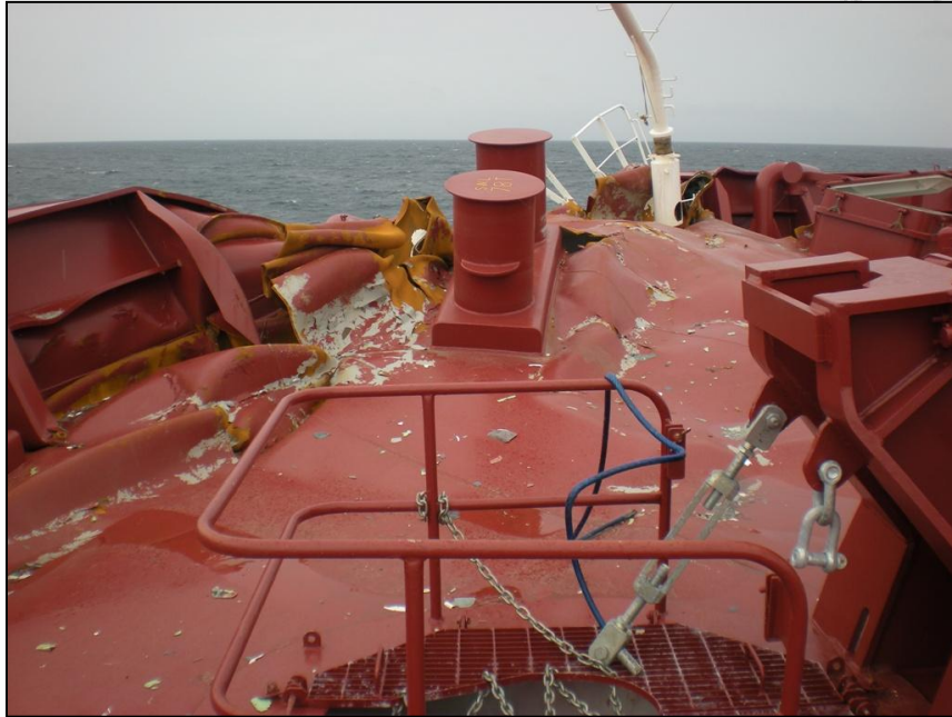
Κατάσταση Πλωριού Καταστρώματος m/v UNIPi
