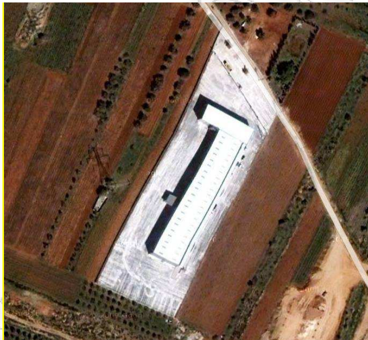
Figure 1-1 Αεροφωτογραφία του κτιρίου αποθήκης και γραφείων
