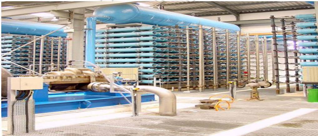
Εικόνα 9 : Το εσωτερικό μιας μονάδας αφαλάτωσης αναστροφής όσμωσης στην Κύπρο 18
