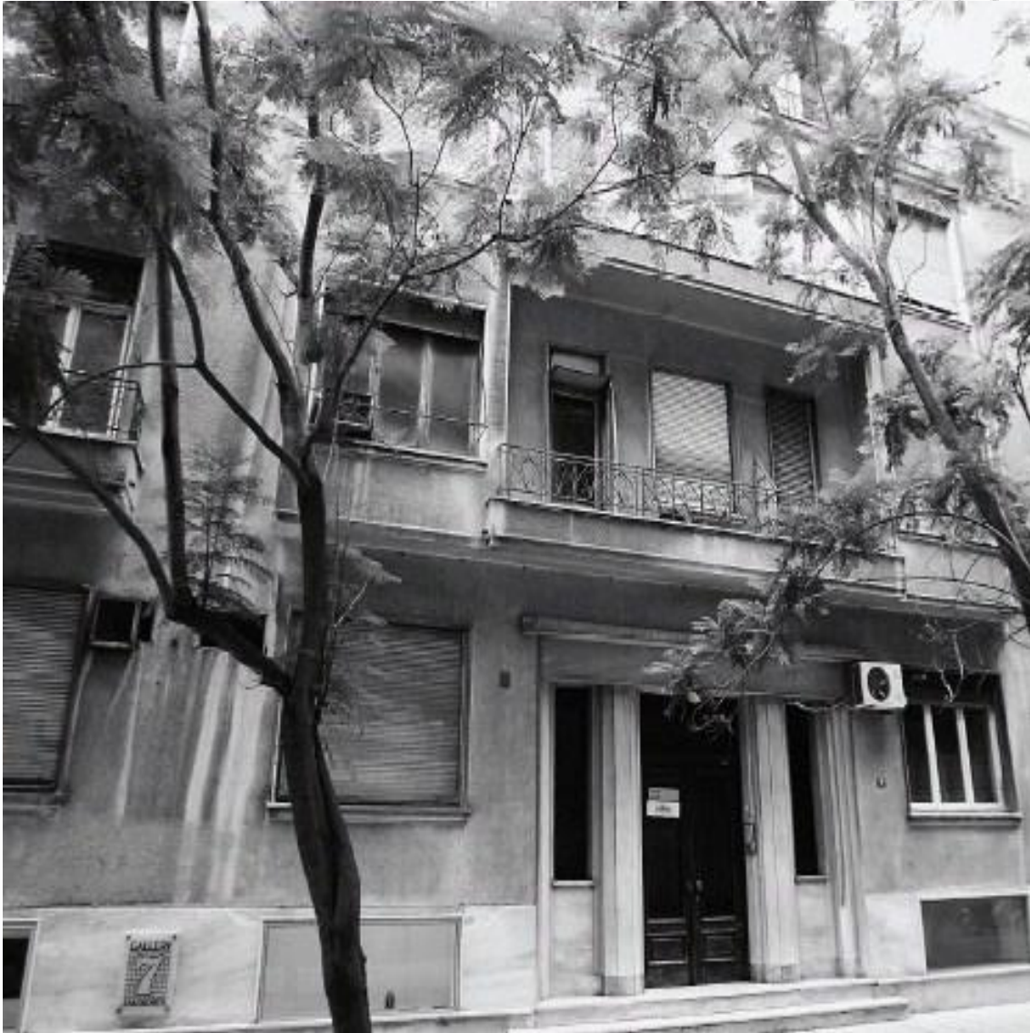
Κτίριο ιδιοκτησίας Ν.Α.Τ. Ζαλοκώστα 7
