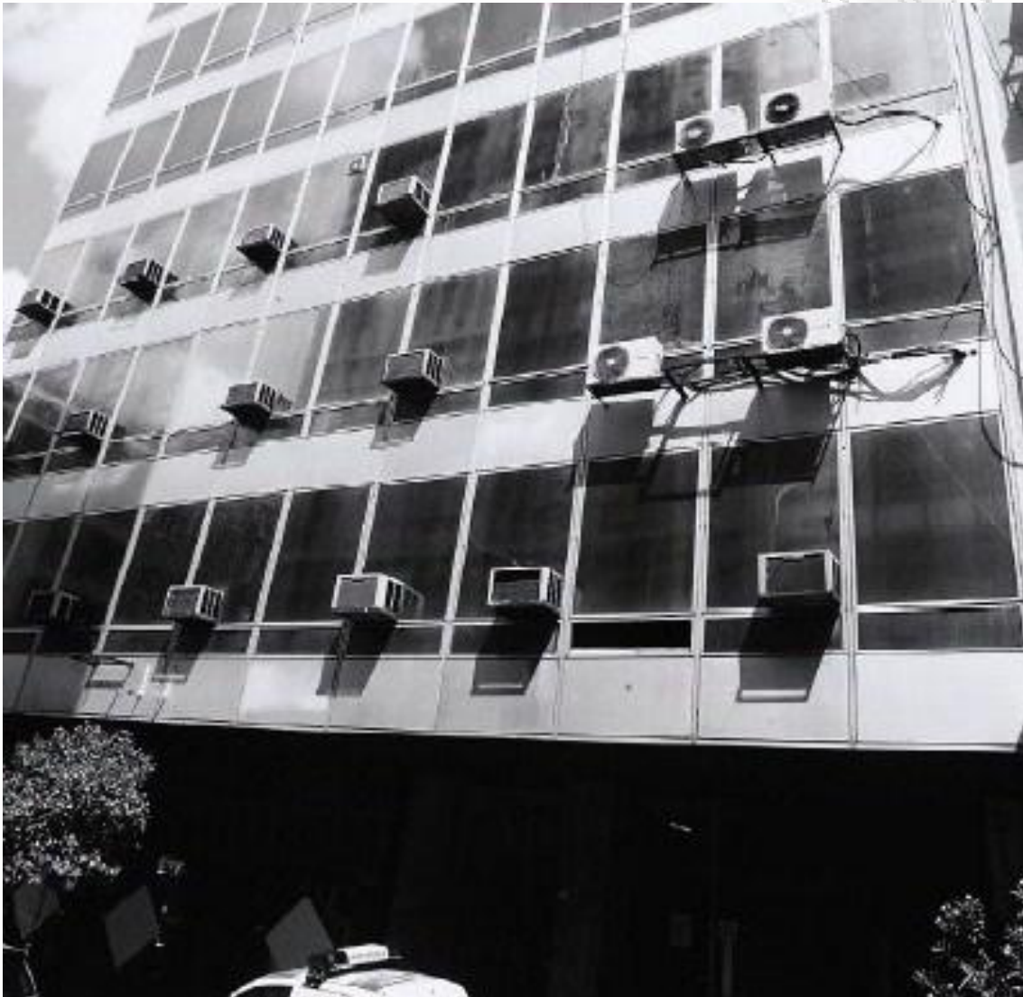
Κτίριο ιδιοκτησίας Ν.Α.Τ. Ομήρου 19 & Ακαδημίας
