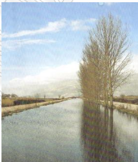
Εικ. 6.5: Τάφρος ανατολικής πλευράς[35]
