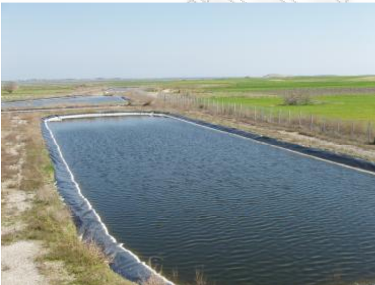
Εικ. 3.2: Λίμνη σταθεροποίησης
