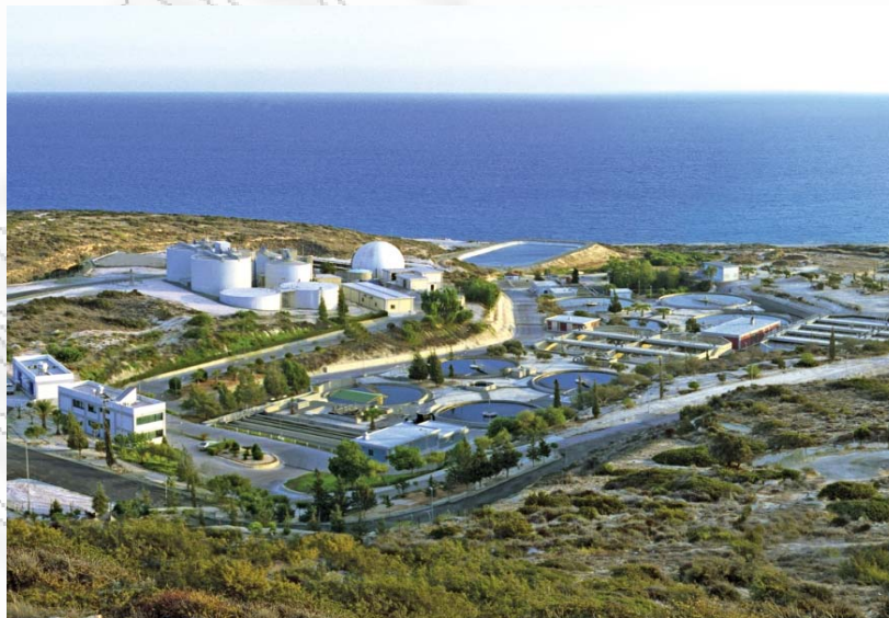
Σχήμα 1.4: Μονάδα επεξεργασίας υγρών αποβλήτων, Μονή, Λεμεσός, Κύπρος
