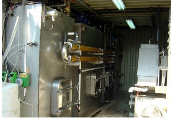
Το σύστημα MBR της ΤΠΠ που μπορεί να διαχειριστεί λύματα σε μια ευρεία γκάμα πλοίων.
