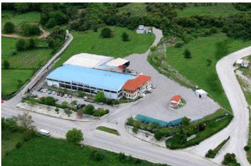
Βιομηχανική μονάδα εμφιάλωσης νερού - Περιβλεπτος Ιωαννίνων Water bottling factory - Perivleptos Ioanninon
