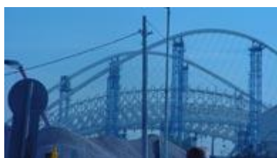
Αθήνα 2004: Ολυμπιακό Στάδιο ΟΑΚΑ, Στέγη Καλατράβα
