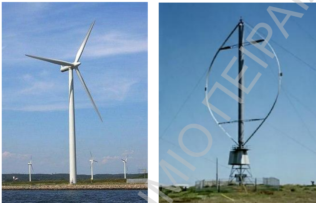
Σχήμα 5.2: Ανεμογεννήτριες οριζόντιου και κατακόρυφου άξονα
