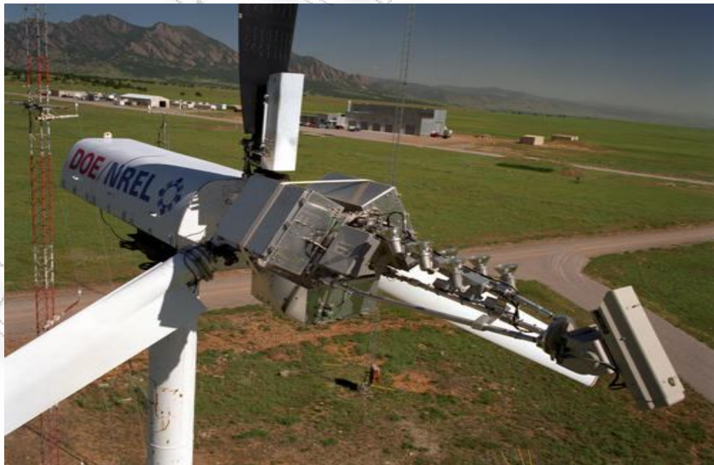
Εικόνα 2. 4 Τοπική ανεμογεννήτρια οριζόντιου δρομέα
