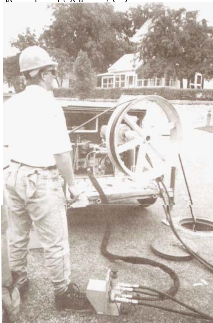
Σχήμα 3.8. Για τραβήγματα μεγάλων αποστάσεων, ο μηχανικός ελκυστήρας εφαρμόζει ομαλή τάση, ενώ ταυτόχρονα παρακολουθείται τυχόν καταπόνηση των οπτικών ινών.
