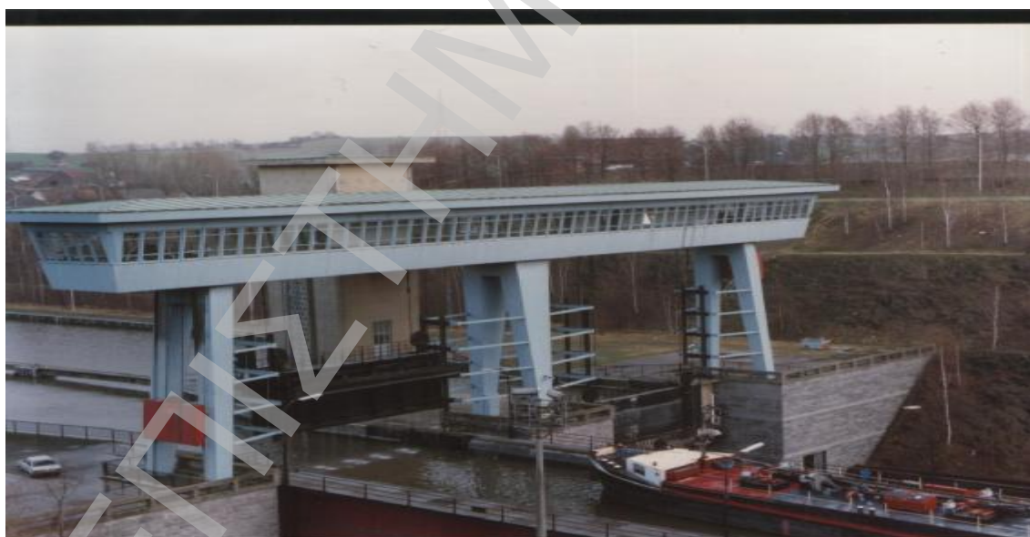
Εικόνα 26: Ο τρόπος λειτουργίας του καναλιού αυτού δεν διαφέρει σε τίποτα από την βασική ιδέα που υπάρχει στο προηγούμενο έργο. Ουσιαστικά έχουμε μπροστά μας δεξαμενές με ανοιγόμενα πλαϊνά, που εξυπηρετούν στην εύκολη και χωρίς διαρροές επικοινωνία των υδάτων, ώστε να μπορούν να περνούν τα πλοία χωρίς ιδιαίτερες καθυστερήσεις. Η όλη διαδικασία
