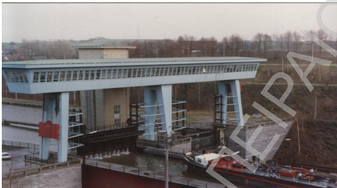
Εικόνα 25: Ξεκινά το άνοιγμα της πόρτας ώστε να επικοινωνήσουν τα ύδατα και να καταφέρει το πλοίο να περάσει στο δεύτερο κανάλι.
