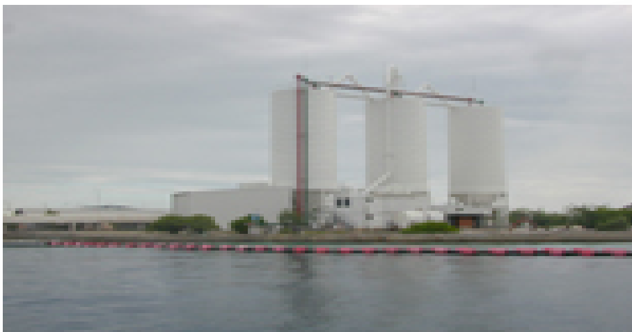
Σταθμός παραλαβής, αποθήκευσης και διανομής τσιμέντου (Onshore –Land- import & distribution Cement Terminal)
