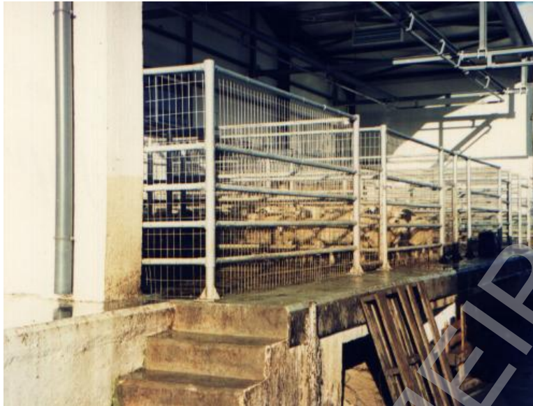
Εικόνα 1.6: Στάβλοι αναμονής στο Δημοτικό Σφαγείο Αγίας Βαρβάρας, Ηρακλείου. Πηγή: Αρχείο συγγραφέως.
