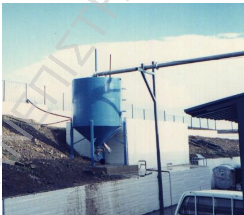
Εικόνα 1.25: Σιλό συγκέντρωσης περιεχομένου εντέρων για την αποστολή με βυτιοφόρο στο βιολογικό αστικών λυμάτων (Δημοτικό Σφαγείο Αγίας Βαρβάρας, Ηρακλείου). Πηγή: αρχείο συγγραφέως.
