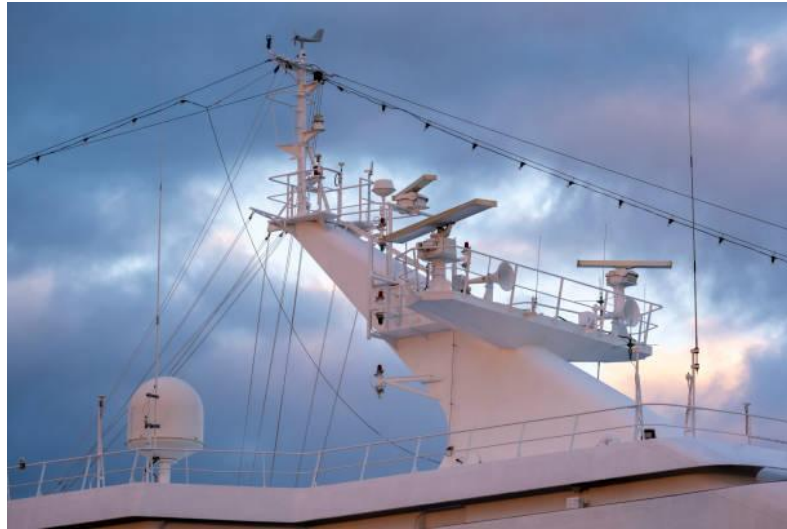
Εικόνα 41 : GMDSS Antennas στον Ιστό πλοίου (Πηγή https://www.istockphoto.com/photos/navigation-antenna-of-cruise-liner )
