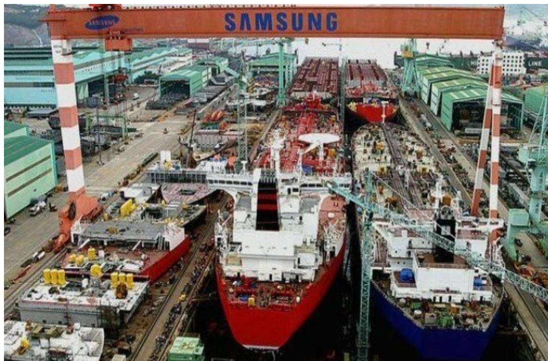
Εικόνα 3 Το ναυπηγείο Samsung Heavy Industries στην Νότια Κορέα
