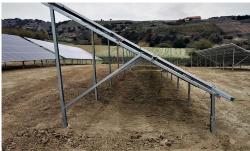
Εικόνα 5: Όψη τη συστοιχίας Φωτοβολταϊκών panels
