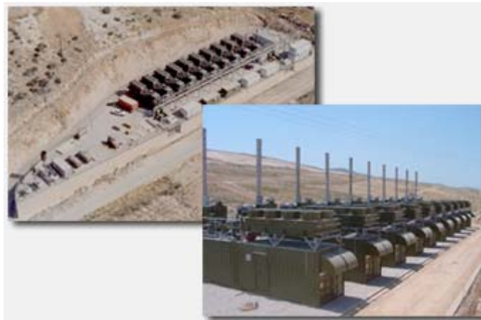
Εικόνα 6: Μονάδες παραγωγής ηλεκτρικής ενέργειας με βιοαέριο
