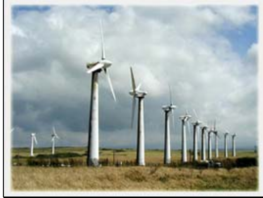
Εικόνα 2: Ανεμογεννήτριες στο Μπιλμπάο της Ισπανίας
