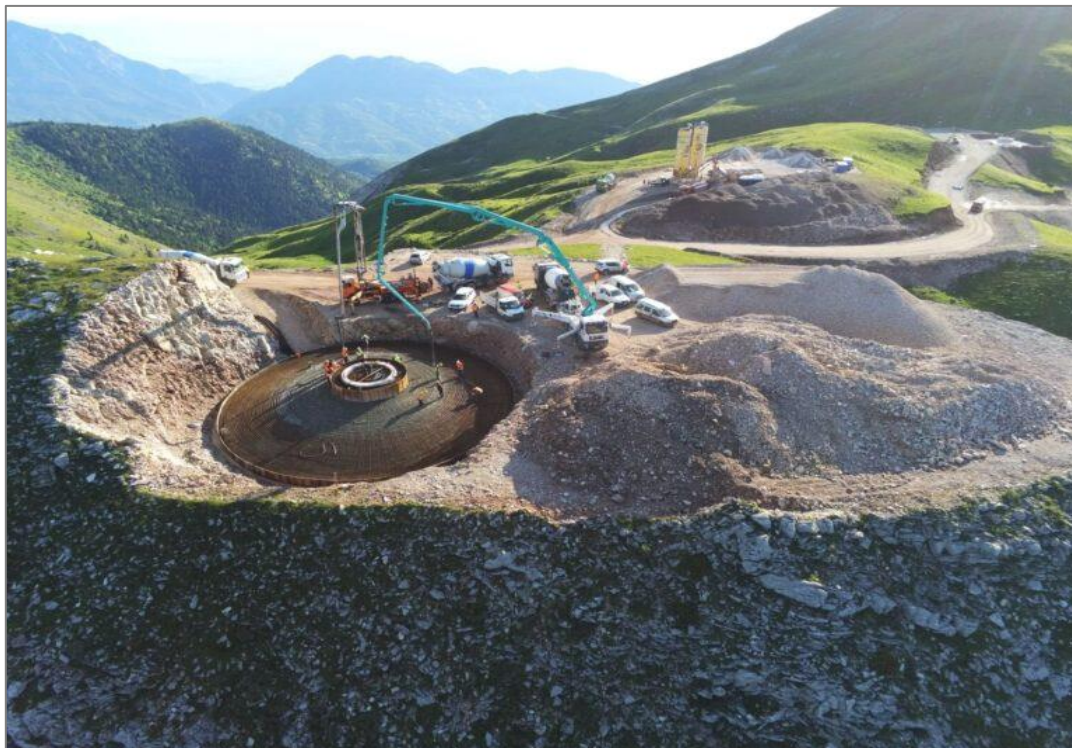
Εικόνα 24: Κατασκευή βάσης ανεμογεννήτριας στα Άγραφα (πηγή: περιοδικό Ανεβαίνοντας)
